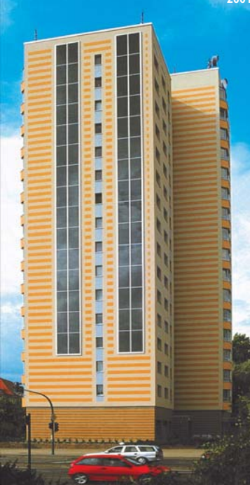
Immeuble à Potsdam Fonctionnement sans encombre depuis 2001
