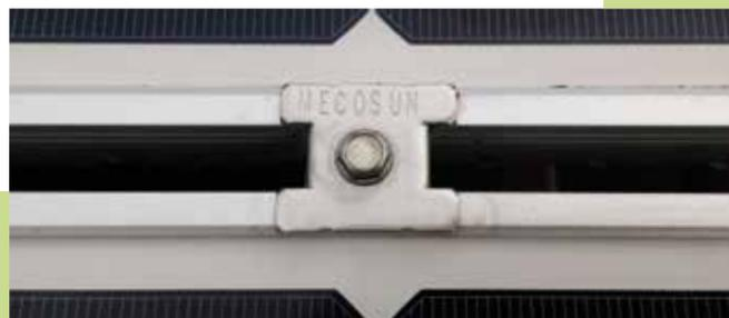
La mise à la terre des modules se fait lors du serrage des serreurs de fixation.
