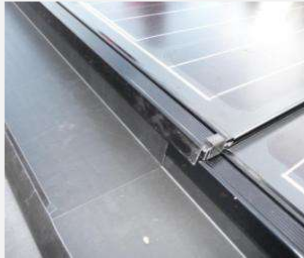
Vue du recouvrement des abergements
