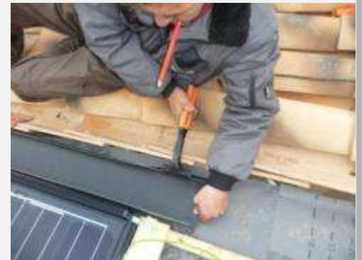
Ajustement à la pince à border
