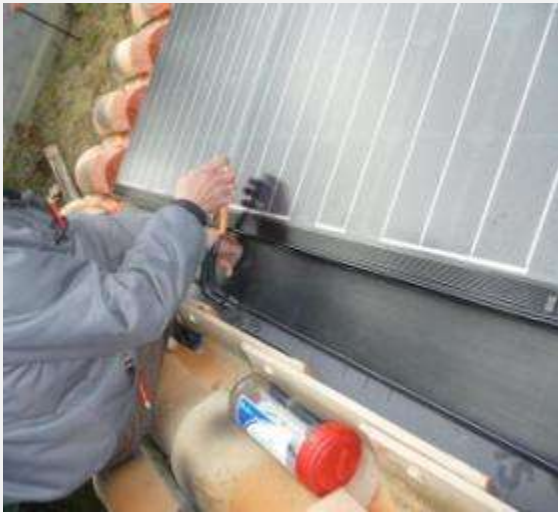
Ajustements aisés à l'aide d'une pince à border
