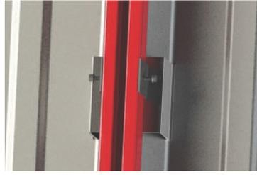
Fixation des rails par vis inox 4,8 x 13 mm (2 vis par platine)
