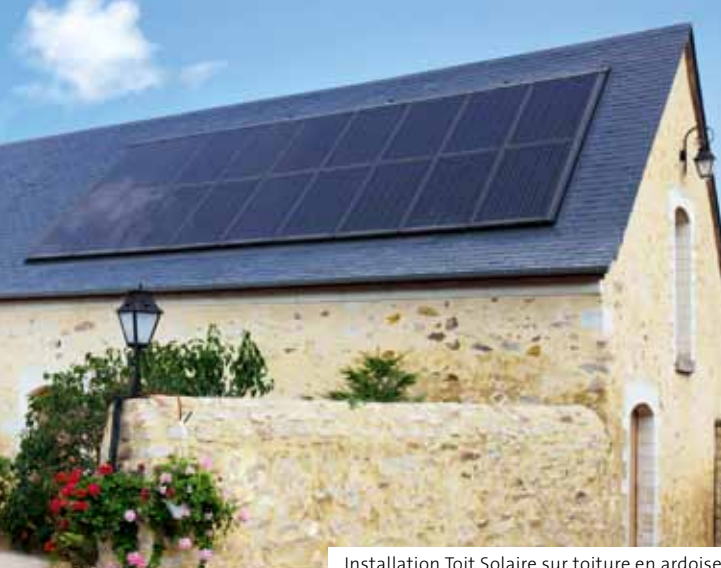
Installation Toit Solaire sur toiture en ardoise
