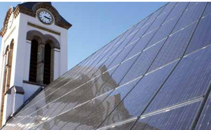
« Coup de coeur » du concours de photo 2010 - Qualit'EnR / Installation Toit Solaire en toiture complète
