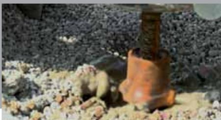
Infiltration de mortier au ciment par le trépan cruciforme
