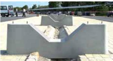
Élément préfabriqué de fondation posé et nivelé
