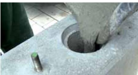
Coulage des fondations avec le mortier de scellement
